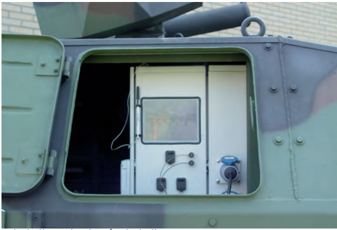
Schakelkast display / schakelkast
