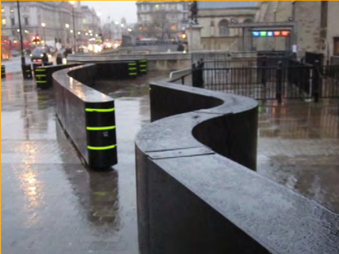
Tijdens de Olympische spelen in Londen werden mobiele systemen gebruikt voor het reguleren van mensenmassa's; deze systemen kunnen ook gebruikt worden in bijvoorbeeld een ingangspartij of de perimeter van een base. (Foto: Corus, Bi-steel)
