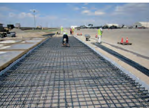
Aanbrengen wapeningsstaal
