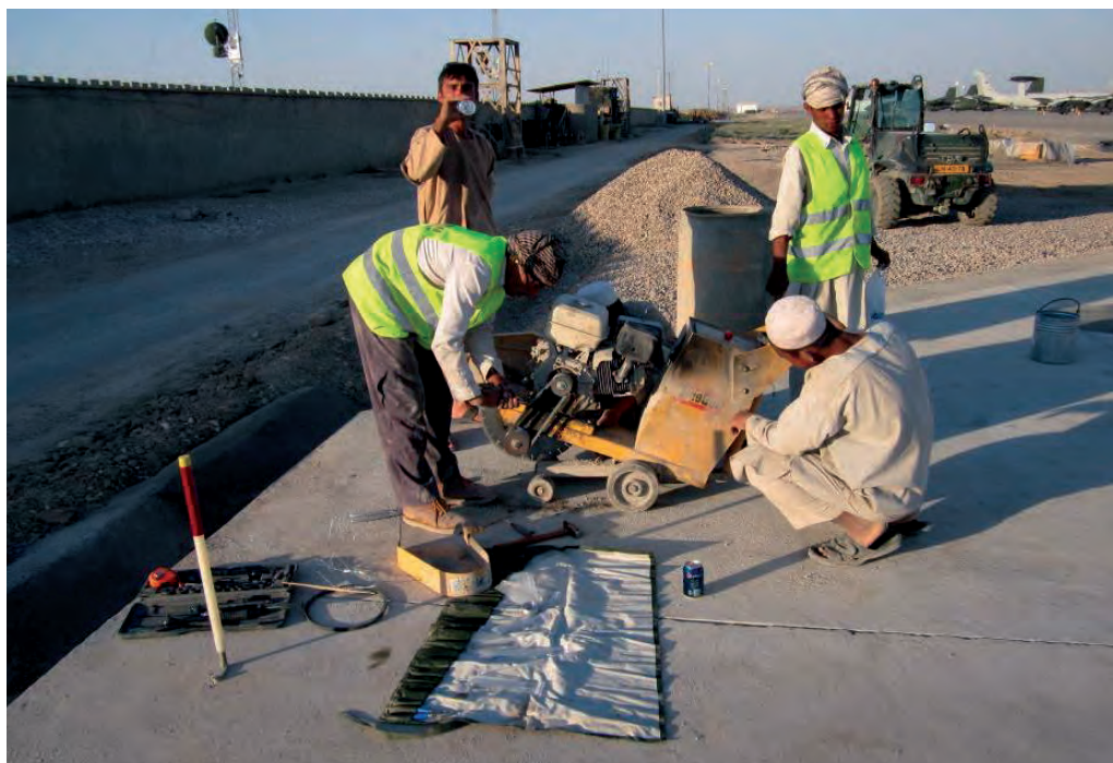
Repareren van de betonzaag
