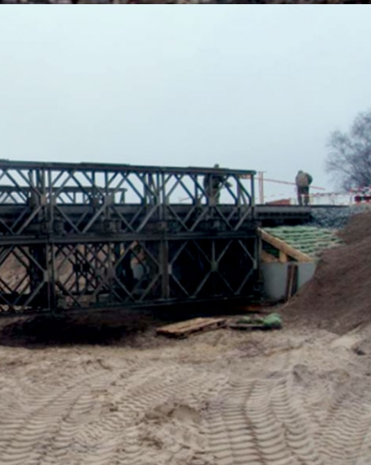
Het te vervangen spoor
