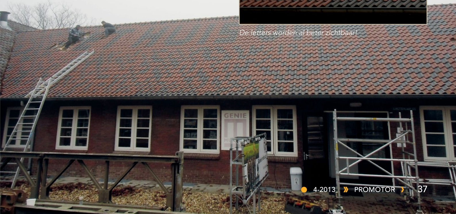
Het dak op en even 3.000 pannen verleggen...
