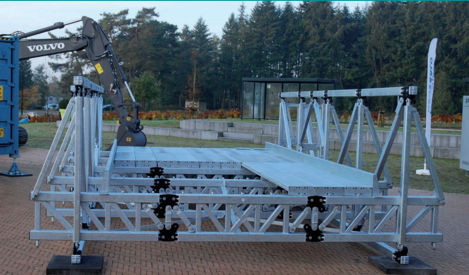
Voorbeeld van een handopbouwbare brugconstructie, voor het eerst gepresenteerd bij het Genie Symposium op 30 oktober 2015
