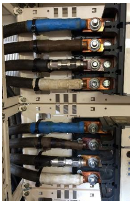
Te heet geworden perskabelschoenen
