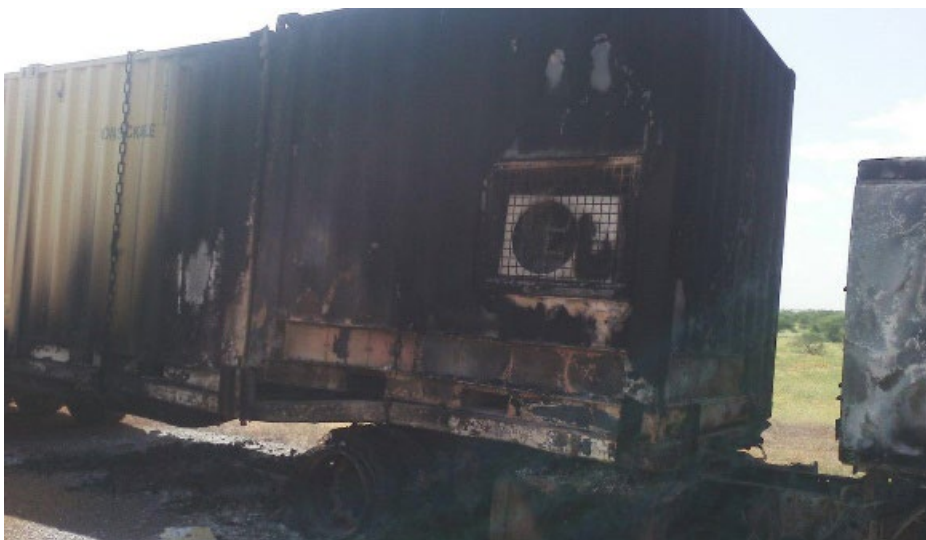
Uitgebrande verdeelcontainers voor powerplant F
